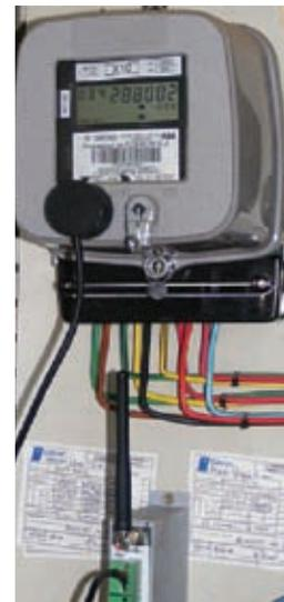
Medidor T3 con módem GPRS dentro del gabinete de medición.
